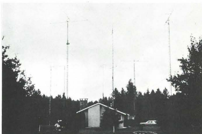
Les 8 pylones d'Henry VE7WJ à Vancouver (Canada)
